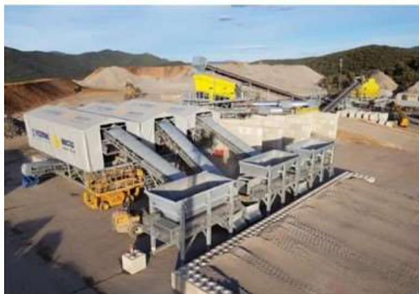
Installation de Maturation et d'Elaboration des mâchefers
