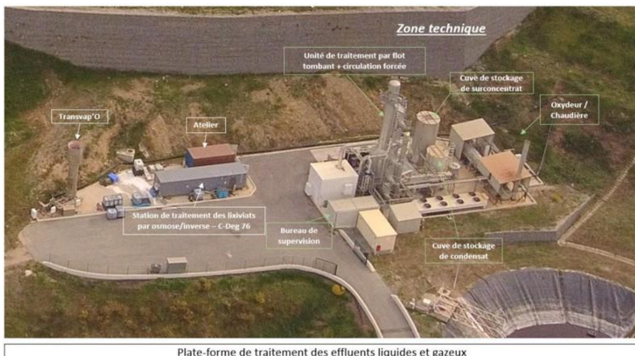
Installation de Stockage de Déchets Non Dangereux avec sa zone technique comportant les équipements de traitement du biogaz et du lixiviat
