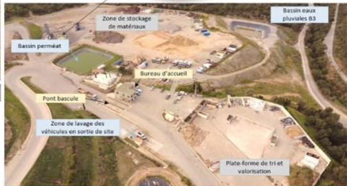
Plate-forme de tri et valorisation des biodéchets, DAE et encombrants
