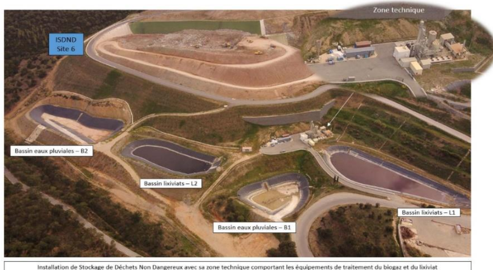
Installation de Stockage de Déchets Non Dangereux avec sa zone technique comportant les équipements de traitement du biogaz et du lixiviat
